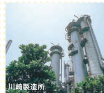
川崎製造所 1959年、国産技術で初めて酸化エチレンを企業化した川崎製造所(千鳥工場・浮島工場で構成)は、現在、国内最大級の酸化エチレン製造装置が稼働しており、酸化エチレンおよびその誘導品を生産しています。
