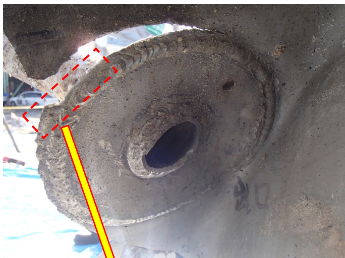
冷却水出口ノズル部 (外面側より観察)
