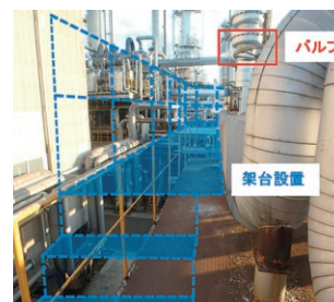
高所でのバルブ操作のための架台設置
