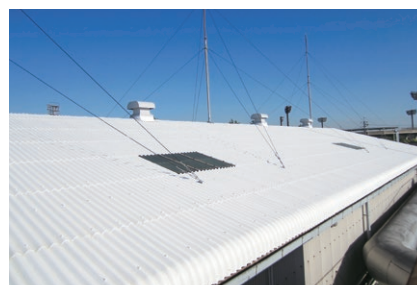
遮熱塗装を施した屋根
