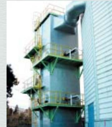
※触媒式ダイオキシン類分解除去装置
