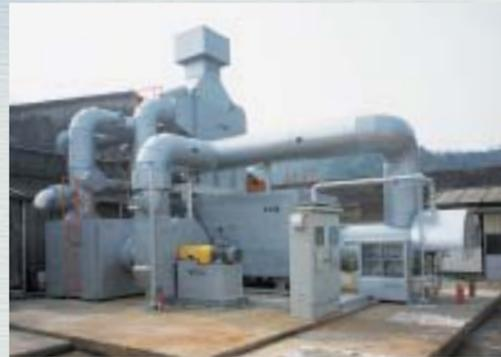
触媒式ダイオキシン類分解除去装置
