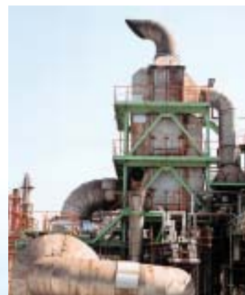
ベンゼンの触媒酸化式排ガス処理装置
