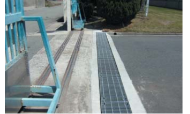
日本ポリマー工業の工場外流出防止溝
