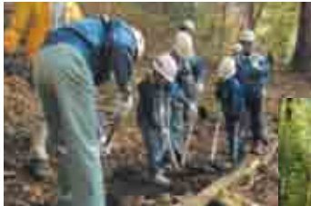
歩道整備作業
