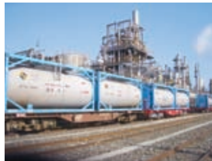
増強した当社主力製品(EO)の鉄道タンクコンテナと荷役充填設備
