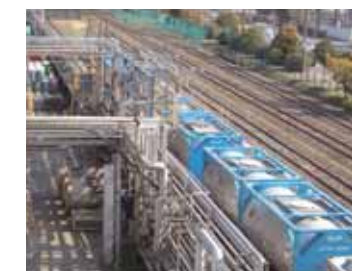
増強した当社主力製品(EO)の鉄道タンクコンテナと荷役充填設備
