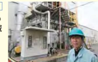
製造工程で発生する有機溶剤ガスを排ガス処理設備で燃焼処理しています。今回はその際に燃料として利用する灯油使用量の削減を目標に取り組みました。設備の立ち上げ時間のルール化、待機時間を削減することで2013年度比10%燃料使用量を削減することができました。今後も効率的運転に努めて省エネを図っていきます。
