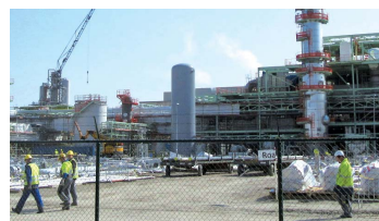
建設中のアクリル酸プラント
