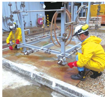
配管外しトレーニング
