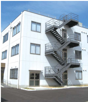
新管理棟 東面より
