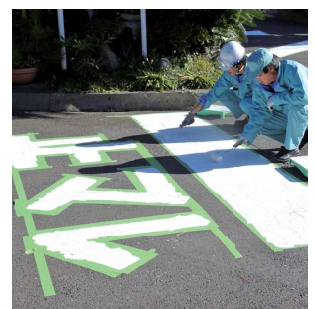
道路舗装の補修状況
