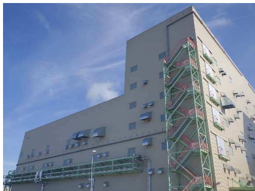
写真（左）高吸水性樹脂製造プラント
