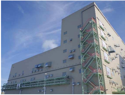
写真（左）高吸水性樹脂製造プラント
